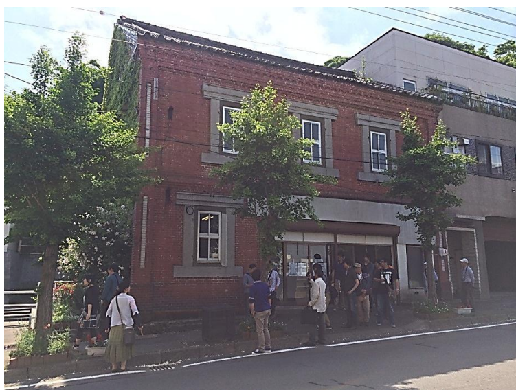
煉瓦造と木骨煉瓦造の混構造を採用している丸越山口紙店
