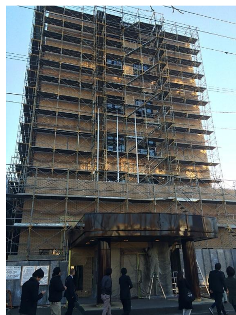
外部改修中の函館市消防本部
