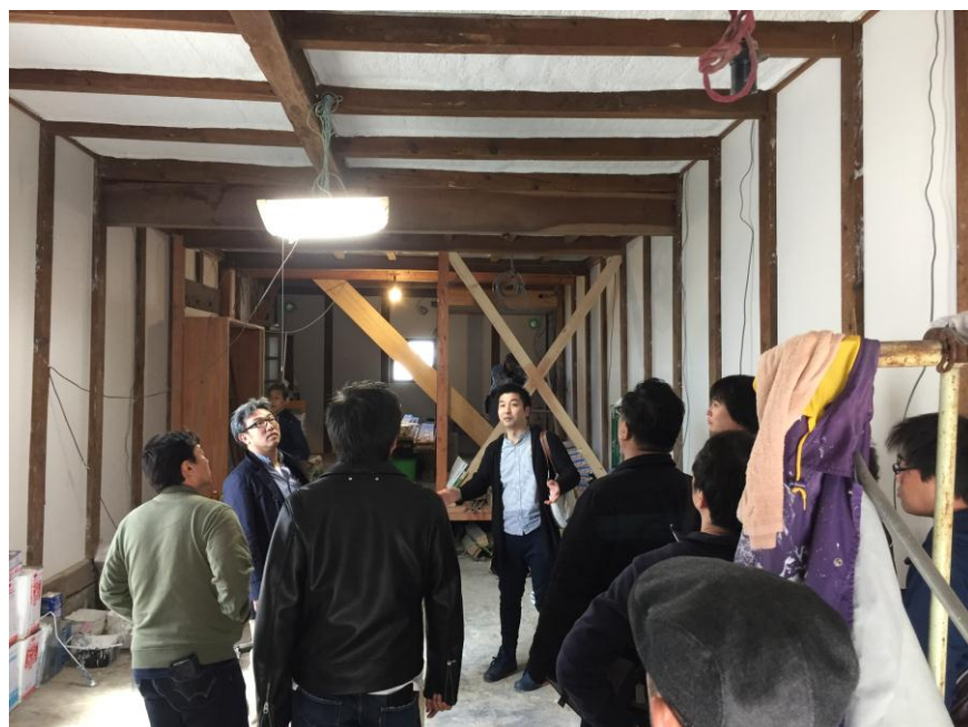
蔵の再生現場＝富樫代表（写真中央）による現場説明
