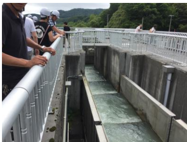
コンクリート製の魚道
