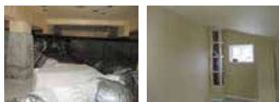
床下の機械と2階のダクト
