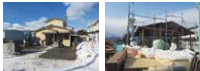
解体前 → 解体後
