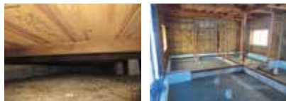
施工前 → 施工後
