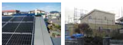
太陽光パネル OSB合板施工
