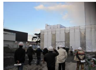
副棟の現場へ
