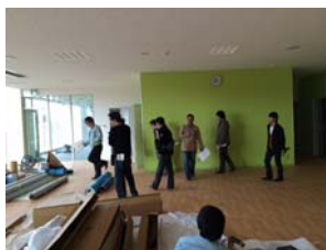
器具類は未設置
