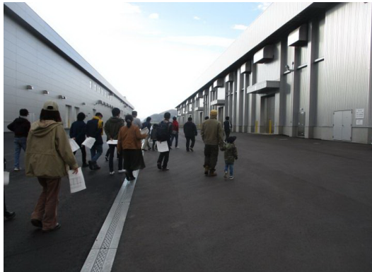
写真① 玉ねぎ冷蔵倉庫
