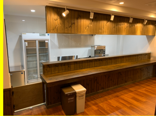
②ミノタケ料理店改築工事
