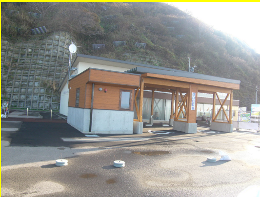
⑤道の駅子育て支援施設新築工事
