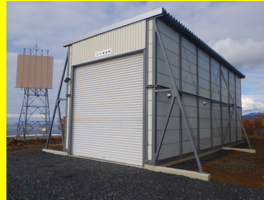
④泊発電所構内ポンプ車庫移設工事
