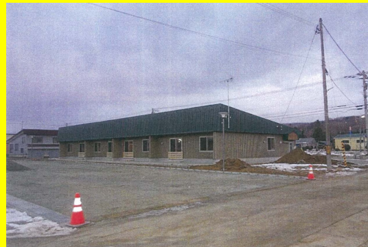
⑥白井川団地2号棟新築工事
