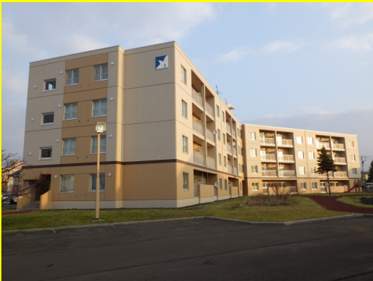
③東山団地3号棟外壁改修工事
