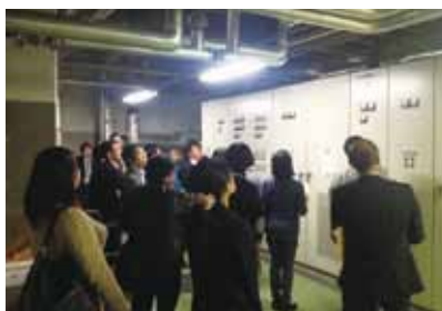
「設備セミナー」この規模の建物になると、機械設備が大きくて迫力があります。
