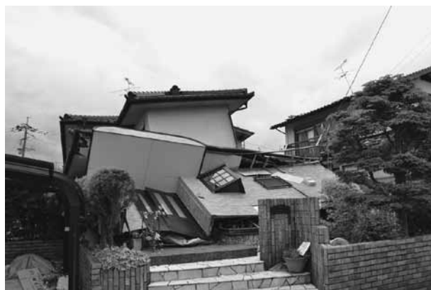
写真1 木造住宅1階部分の崩壊
