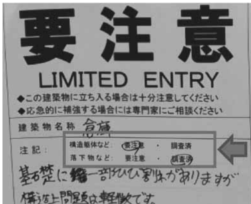
写真7 落下物が躯体かをチェックできるステッカーの例（益城町）
