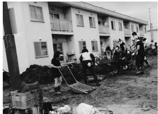
汚泥を処理するボランティアの皆さん
