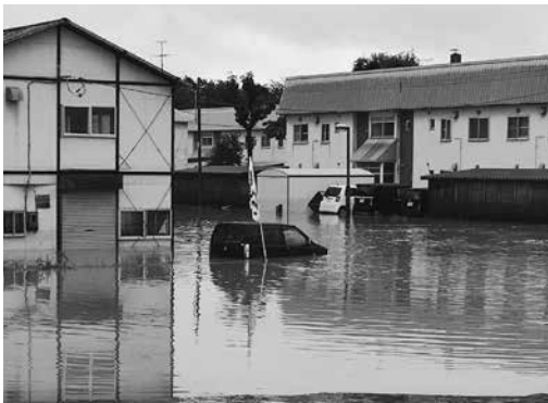
河川の氾濫による建物への浸水状況
