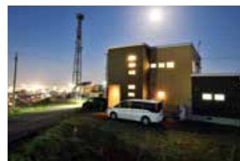
写真：上段/多目的スペース 左下段/食堂 右下段/外観
