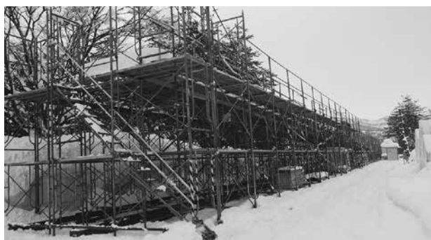
写真1 屋外実験の様相 (屋根長さ50m、勾配2°)
