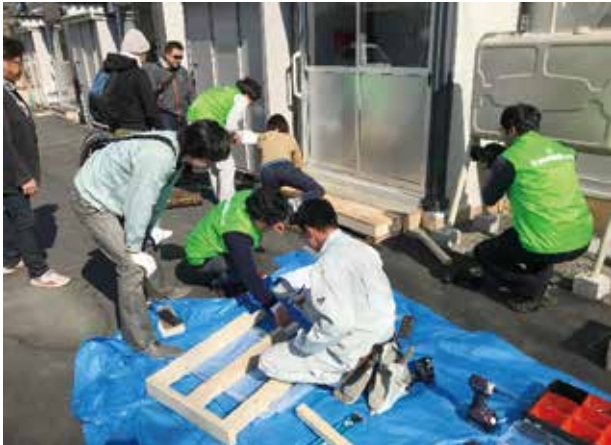
仮設団地で玄関ステップ拡幅の作業
