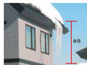
写真3 換気や断熱気密が不足し氷柱が発生している例
