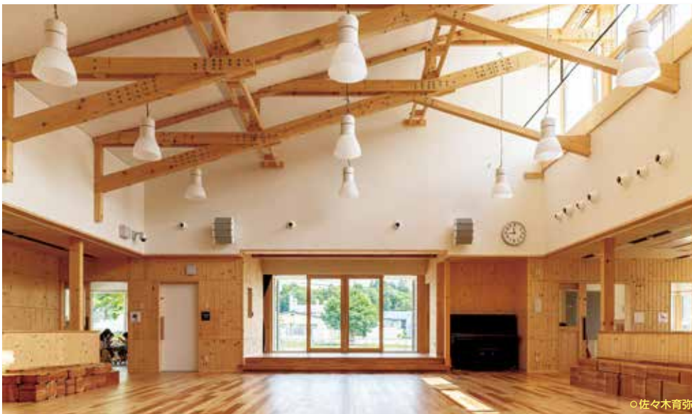
村産針葉樹のトラスと柱によって構成された遊戯室
