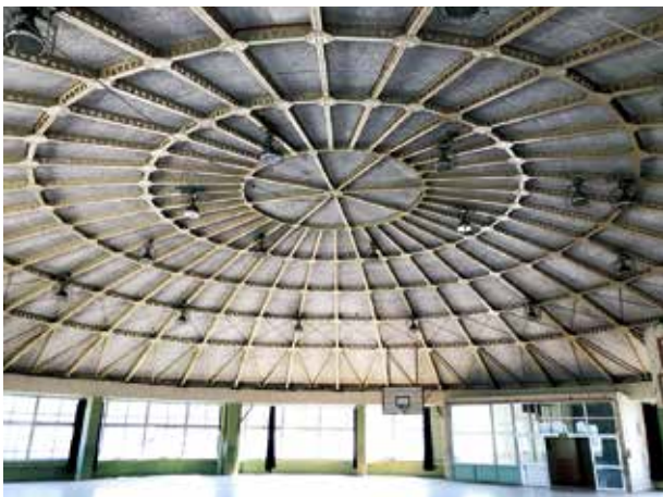
体育館棟の屋根の鉄骨組
